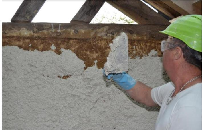
Ainsi, l'enveloppe de la grange est entièrement perméable à la vapeur d'eau grâce au recours aux applications chaux-chanvre et chaux sable en remplissage de mur et en enduits.
